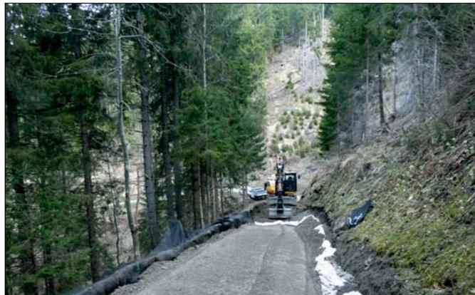
Stabilisierung des Straßenkörpers zur Verbesserung der Tragfähigkeit bei der Hofzufahrt Feichter
