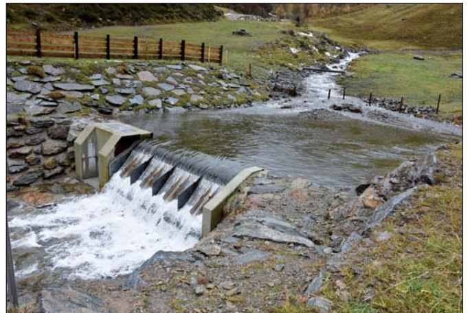
Die Wasserfassung beim Zusammenfluss von Gampen- und Jakober Alm Bach
