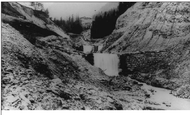
Eine der ältesten Wildbachverbauungen: Kristeinbach oberhalb von St. Justina (um 1883 – 1890); im Hintergrund die Hofstelle „Platzer“ in Vergein
