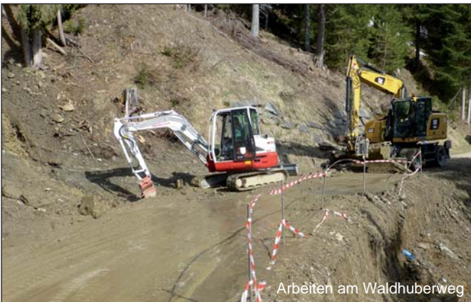
Arbeiten am Waldhuberweg
